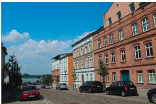
Historische Häuserfassaden in Prenzlau
